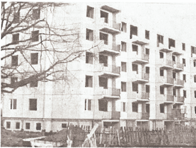
Pięciopiętrowy budynek wznoszony przez Spółdzielnię Mieszkaniową Lokatorsko-Własnościową.
