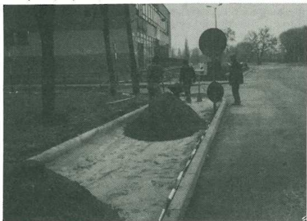
Zdjęcie przedstawia roboty związane z ułożeniem nowych chodników na ulicy Dworcowej, obok budynku, w którym znajduje się Biblioteka Miejska.
